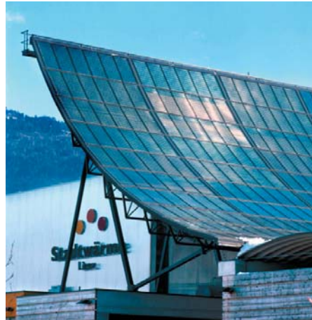
Instalación para calefacción de distrito. Lienz, Austria. Fuente: S.O.L.I.D.
