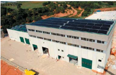
Instalación solar térmica para calor de procesos industriales en Barcelona
