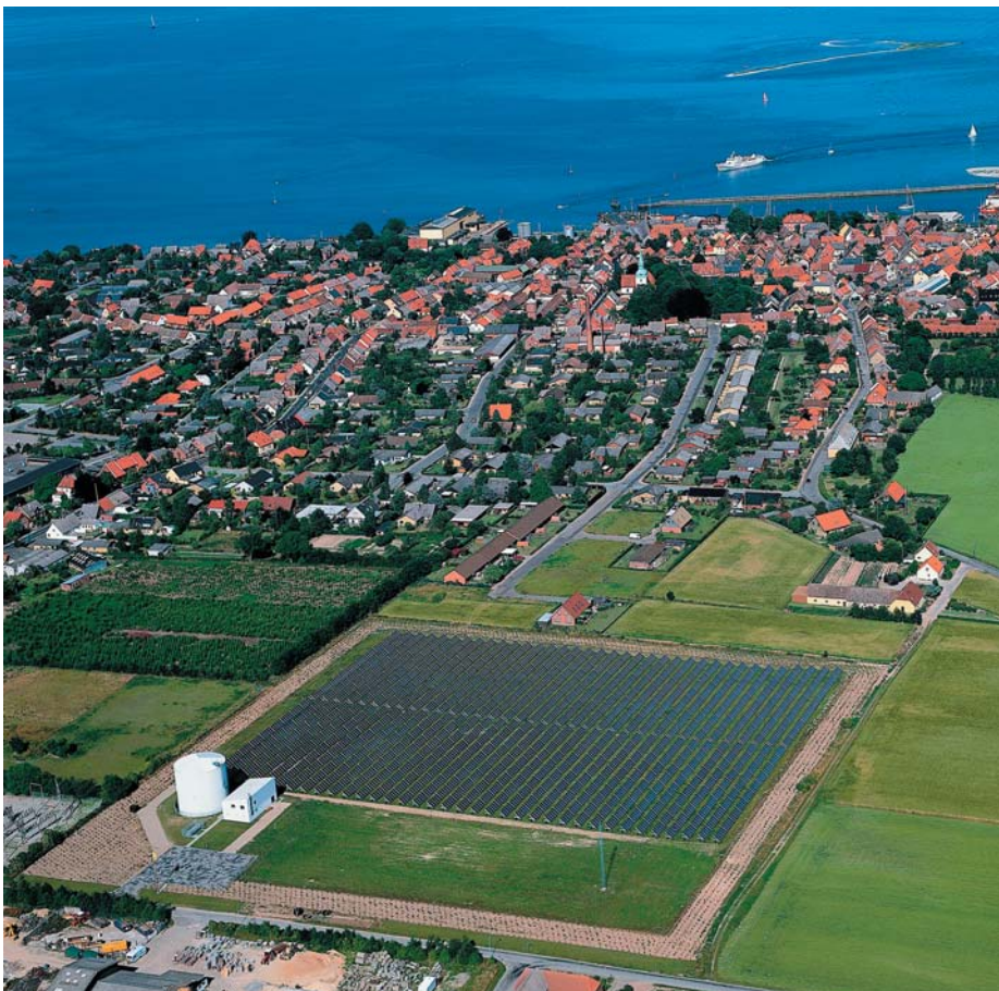
Planta solar de 20.000 m 2 en Marstal, Dinamarca. Fuente: ESTIF
