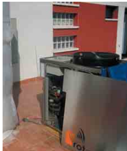
Máquina de absorción ROTARTICA de 4,5 kW.
