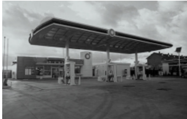
Estación de Servicio BP en Alcalá de Henares
