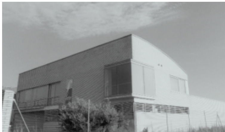
Fábrica de Enertrón en Torres de la Alameda (Madrid).
